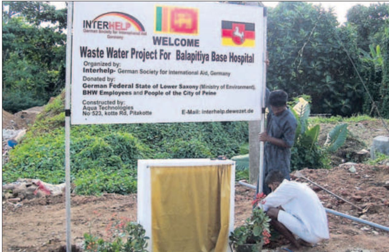
Vorbereitung für die Grundsteinlegung am Krankenhaus in Balapitiya. Das Baustellenschild weist auf den Spendenbeitrag der Peiner Bürger hin. PN-Foto: Verein Interhelp
